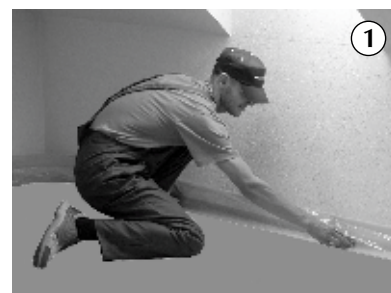
Kladenie dilatčného pásu
