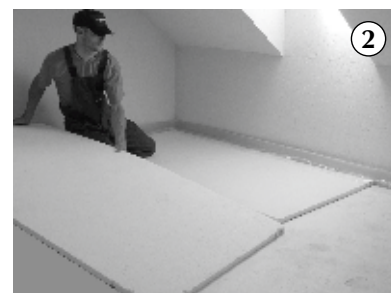
Kladenie tepelnej izolácie
