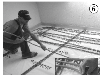
Ukladanie vykurovacích rúrok
