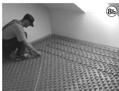
Ukladanie vykurovacej rúrky
