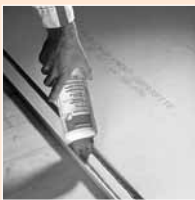
Nanášení podlahového lepidla FERMACELL do polodrážky
