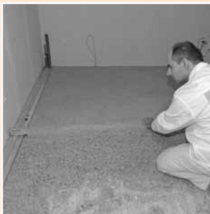
Po provedení nánosu podsypu mezi pásy je nutno jej vyrovnat. Pomocí hladicí lžice vyrovnejte nerovnosti
