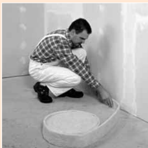
Upevnění krajních izolačních pásek
