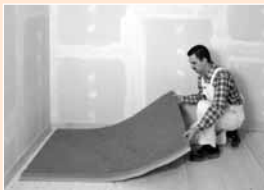
Pokládání podlahové voštiny FERMACELL
