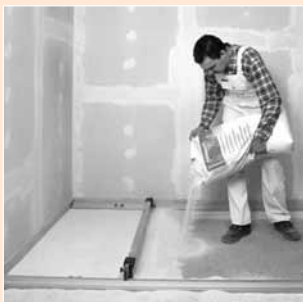
Použití vyrovnávacího podsypu FERMACELL
