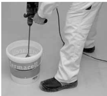
Příprava v čisté nádobě: 6,5 l vody na jeden pytel
