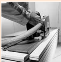
Odříznutí přesahující polo-drážky pro první řadu pokládaných podlahových prvků
