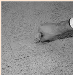
Po provedení nánosu podsypu mezi pásy je nutno jej vyrovnat. Pomocí hladicí lžice vyrovnejte nerovnosti
