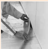
Nalepte okrajové izolační pásky a v rozích proveďte sražení na tupý úhel
