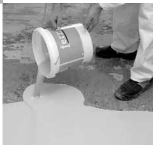
Nivelační hmotu vylijte a vyrovnajte
