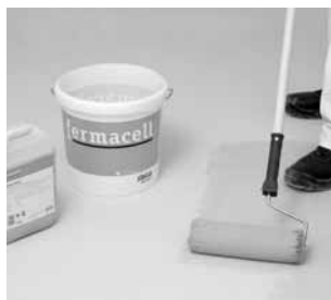
Příprava: proveďte základní nátěr podlahy a položte okrajové izolační pásy
