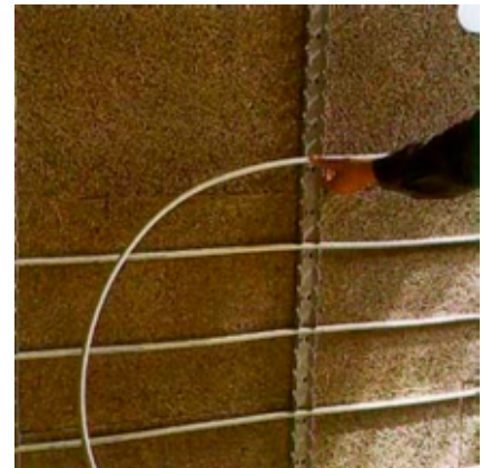
Montáž vykurovacej rúrky
