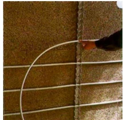
Montáž vykurovacej rúrky
