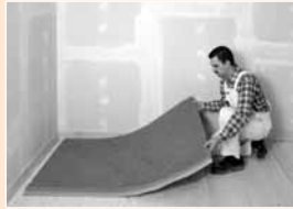
Pokládání podlahové voštiny FERMACELL
