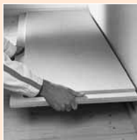
Pokládání podlahové prvky FERMACELL
