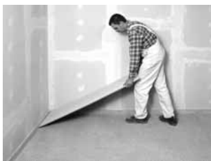
Pokládání podlahových prvků FERMACELL
