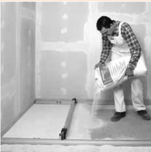
Použití vyrovnávacího podsypu FERMACELL
